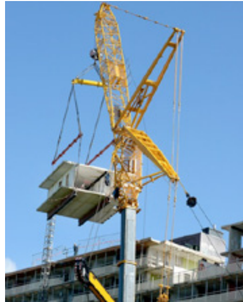
Hergebruik van delen van een bestaand flatgebouw in Kerkrade in expowoningen. Bron: Elma Durmisevic
